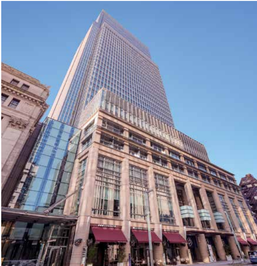
●日本橋三井タワー
