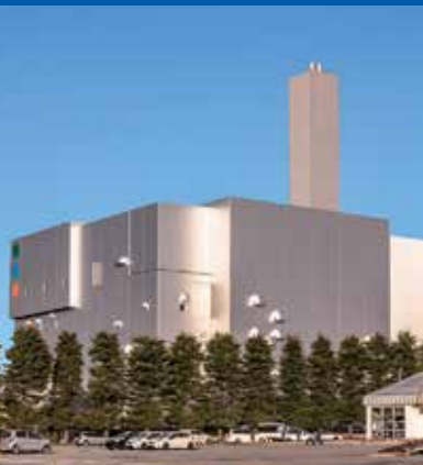
●エネルギー回収施設（立谷川）
